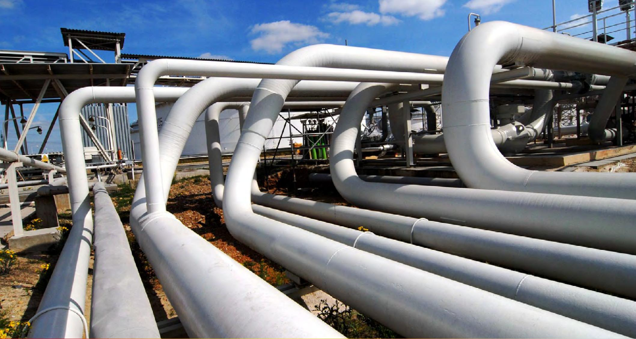
Нарезные трубы нефтяного сортамента (OCTG) включают обсадные и насосно-компрессорные трубы, применяемые при оборудовании и эксплуатации скважин для добычи нефти и газа. Газонефтепроводные трубы предназначены для строительства трубопровода (нефтегазопровода)
